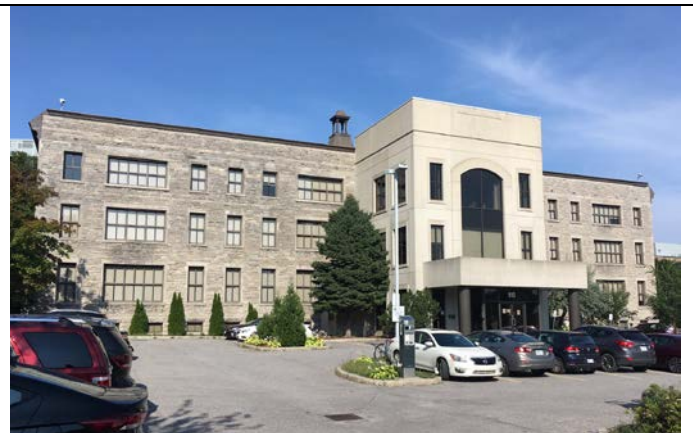
Photo 6 : Façade arrière, septembre 2018
