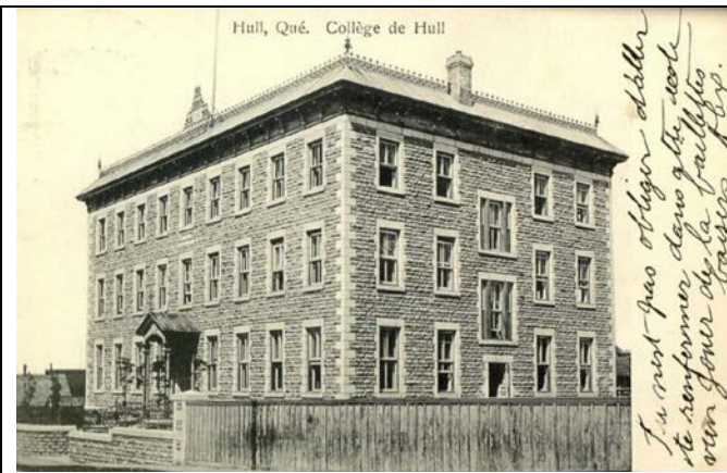
Photo 1 : Façade avant / latérale sud vers 1900. Source : BANQ
