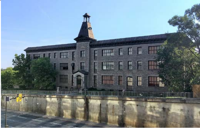
Photo 3 : Façade avant, septembre 2018
