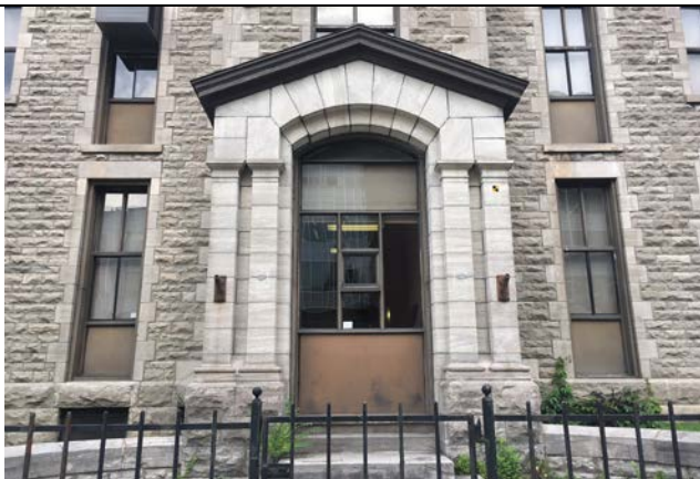
Photo 5 : Détail du portique d'entrée, septembre 2018
