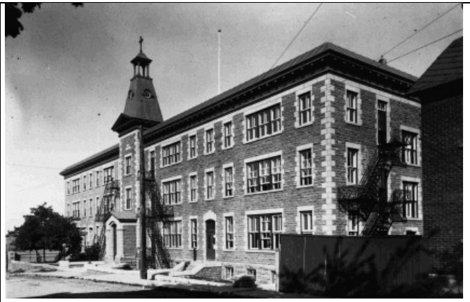
Photo 2 : Façade avant / latérale sud, après 1923 Source : BANQ
